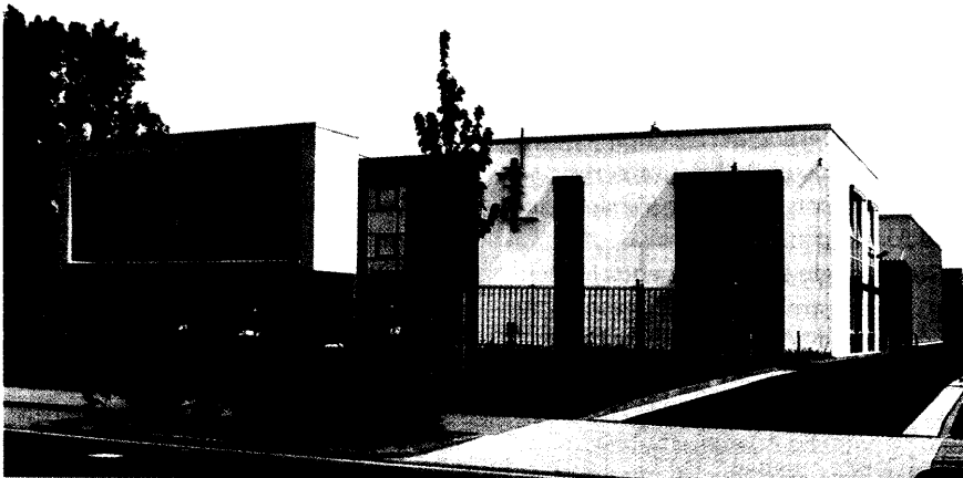
Das neue Firmengebäude der Andreas Fahl Medizintechnik.
